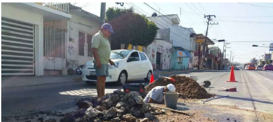
Romper el concreto hidráulico, realizar la excavación para reparar la fuga de agua es uno de las actividades que realizan los compañeros del SIAPA Tepic, Orgullosamente SUTSEMistas.
