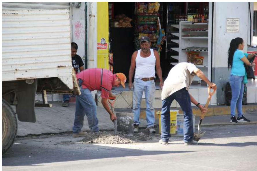
Los trabajadores del SIAPA reparan fugas de agua potable y drenaje a pico y pala.
