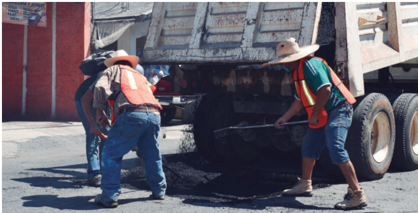
Los trabajadores del Ayuntamiento de Xalisco realizan labores de bacheo.
