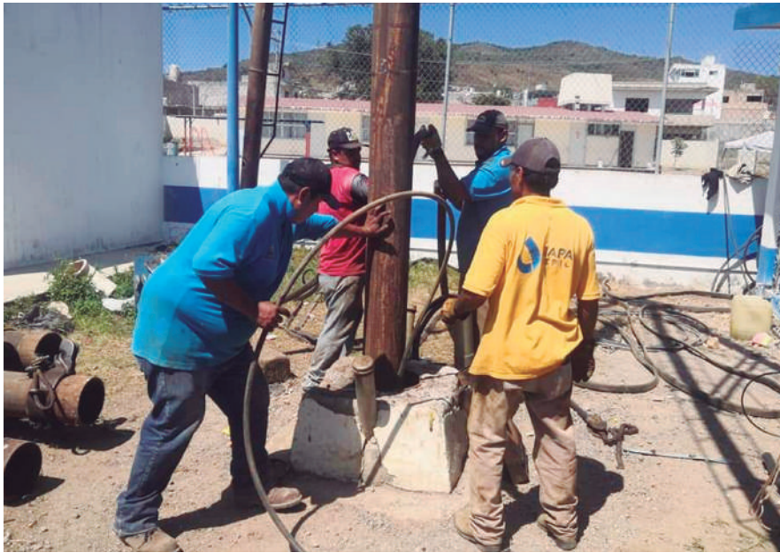
Trabajadores del SIAPA realizando labores de reparación de pozos profundos.
