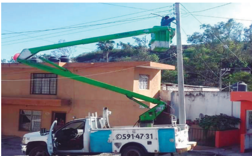
Trabajadores de alumbrado público dan mantenimiento a las lámparas con todo y riesgo que conlleva este trabajo por falta de los implementos de seguridad.
